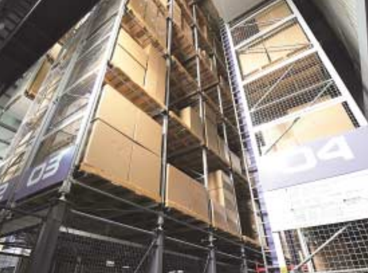
228パレットの収納能力がある増設した立体自動倉庫 立体自動倉庫の大きさは、横1.5m、高さ1.85m、奥行き1.35m
